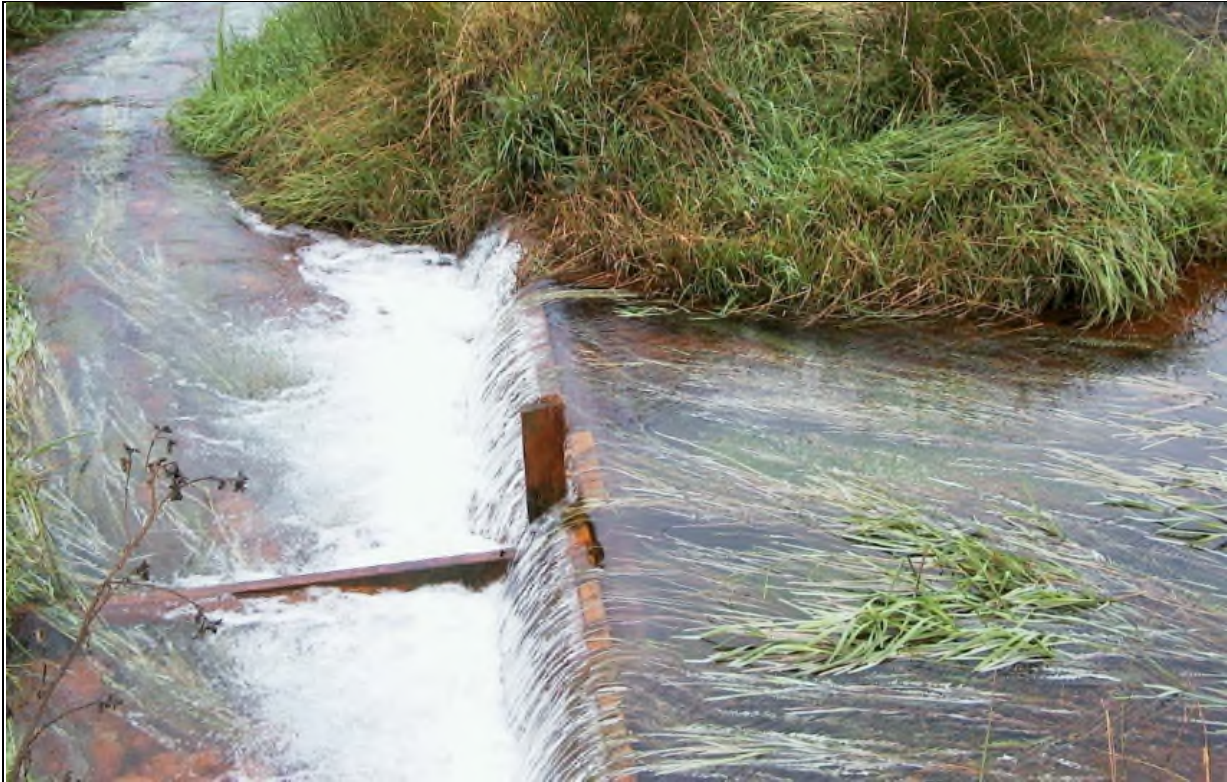
Foto af det rene afløbsvand fra okkerrensingsanlægget ved Hogager Bæk, anlægget blev etableret i løbet af vinteren 1991/92
