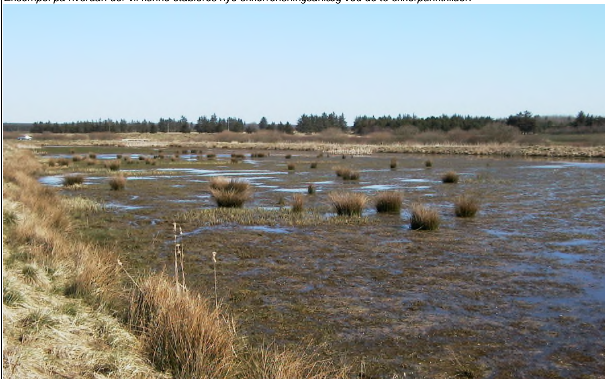
Foto og eksempel på et tidligere etableret okkerrensingsanlæg ved Abild Å, som er et tilløb til Vorgod Å, der ligger øst for Videbæk.
