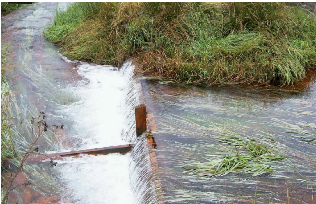
Fig. 6. Foto af det rene afløbsvand fra okkerrensningsanlægget ved Hogager Bæk, anlægget blev etableret i løbet af vinteren 1991/92
