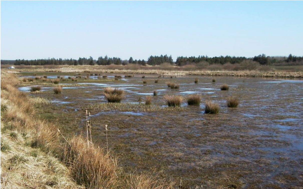
Fig. 16. Foto og eksempel på et tidligere etableret okkerrensingsanlæg ved Abild Å, som er et tilløb til Vorgod Å, der ligger øst for Videbæk.
